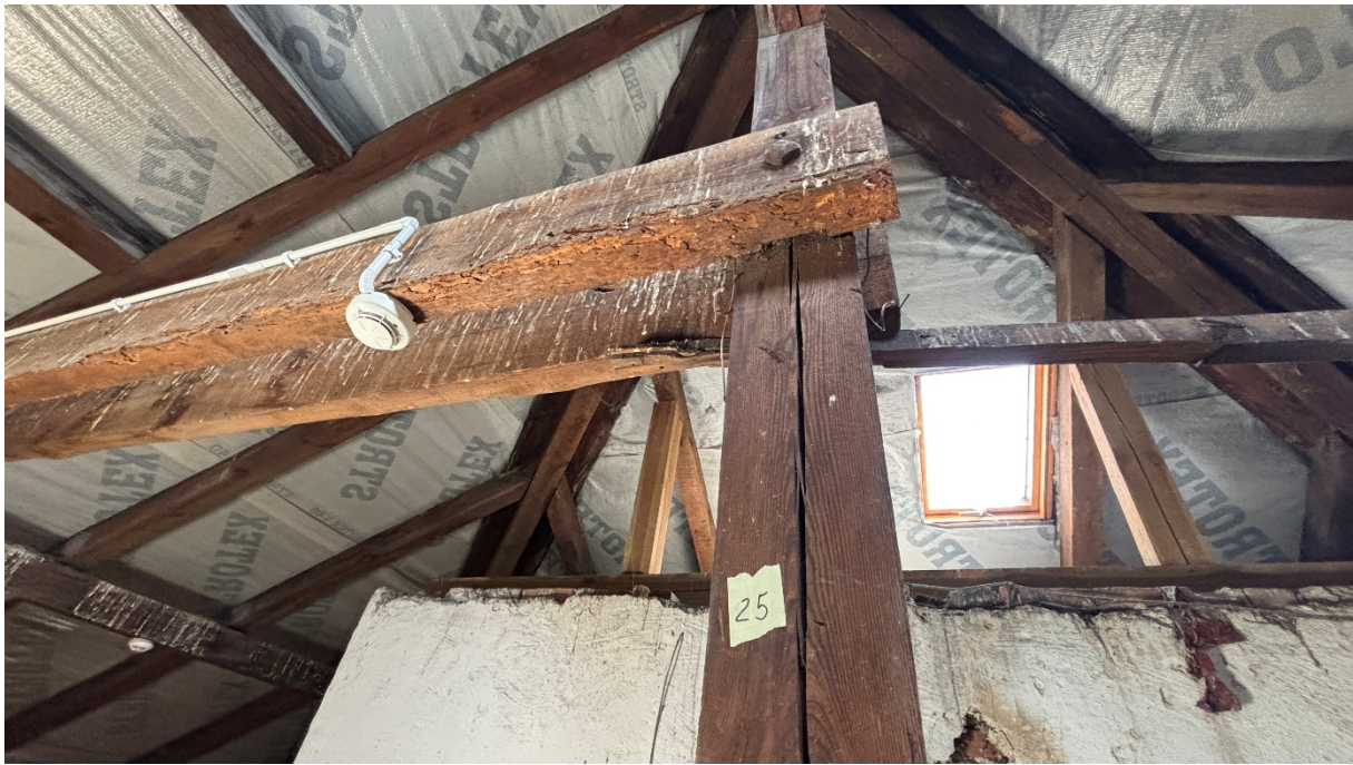
Fot. 51 Nieaktywne żerowiska ksylofaga z gatunku Hylotrupes bajulus . Widoczne głębokie zmiany mikrobiologiczne belek powstałe w wyniku żerowania larw zidentyfikowanego chrząszcza. fot. P. Pakuła 2025r.
