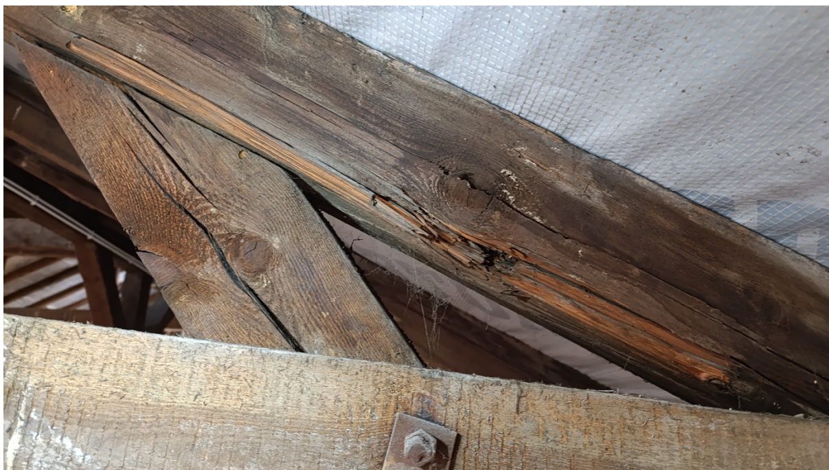
Fot. 25 Uszkodzenie drewna pod wpływem dużego obciążenia lub uszkodzenia mechanicznego. fot. E. Wilbik 2025r.
