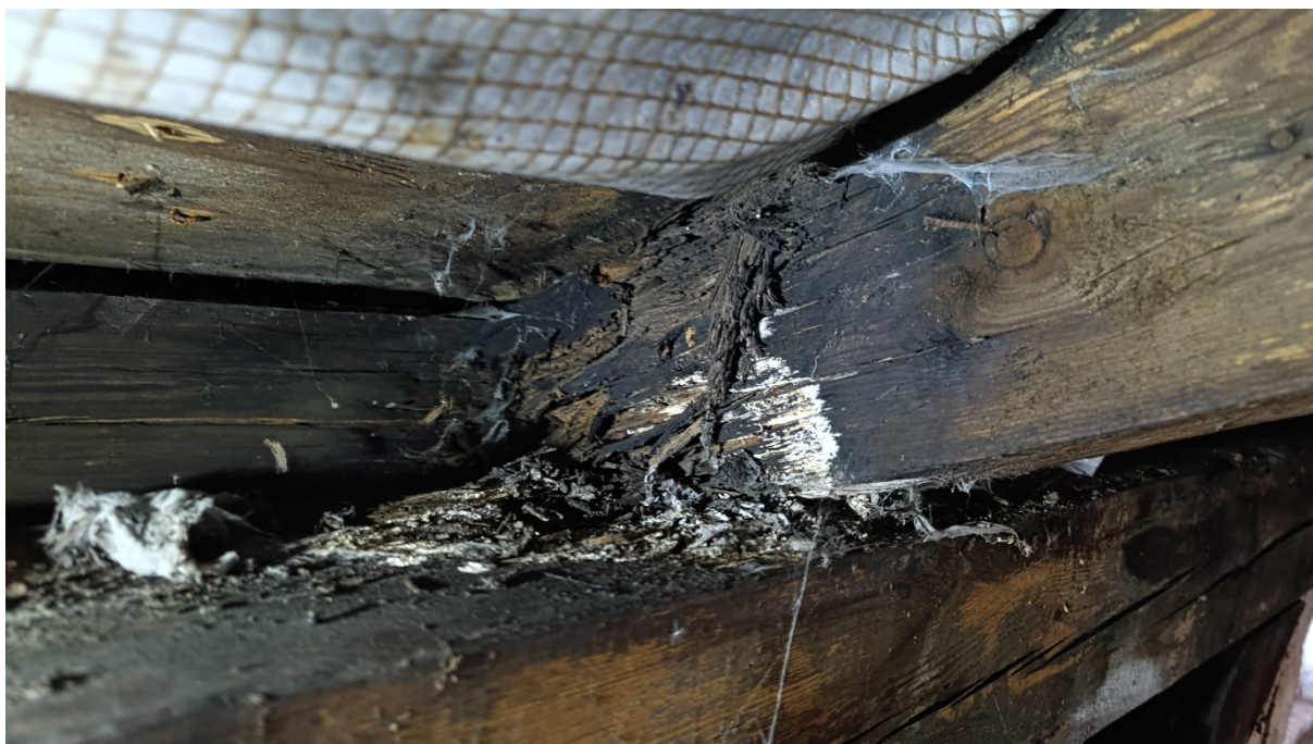
Fot. 3. Korozja biologiczna krokwi spowodowana porażeniem drewna przez grzyb domowy z gatunku Trechispora farinacea Fot. E. Wilbik 2025r.
