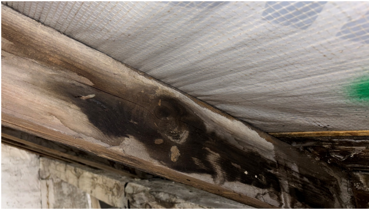
Fot. 5 Zmiany kolorystyczne będące następstwem zawilgocenia drewna. Fot. E. Wilbik 2025r.
