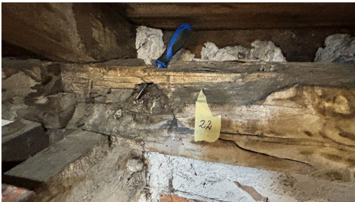
Fot. 9 Uszkodzenie mechaniczne płatwi fot. P. Pakuła 2025r.
