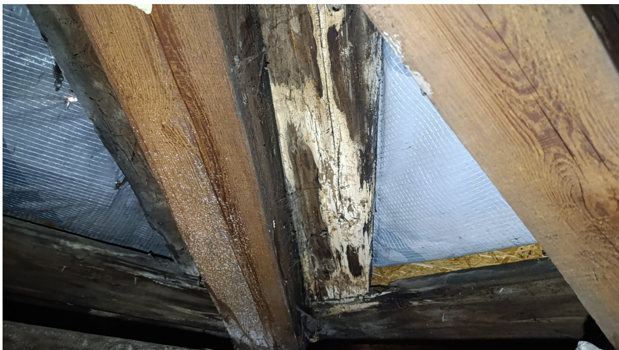
Fot. 17 Grzybnia i owocniki grzyba domowego z gatunku Trechispora farinacea fot. E. Wilbik 2025r.
