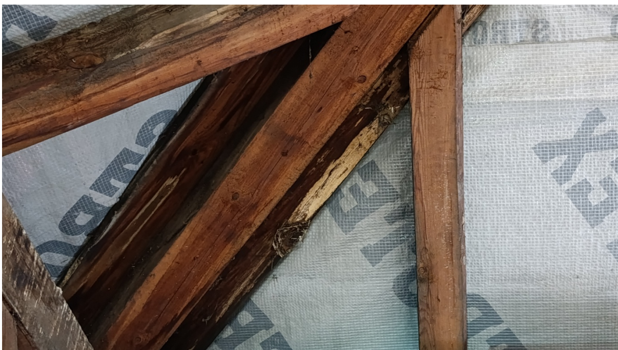
Fot. 22 Grzybnia i owocniki grzyba domowego z gatunku Trechispora farinacea fot. E. Wilbik 2025r.
