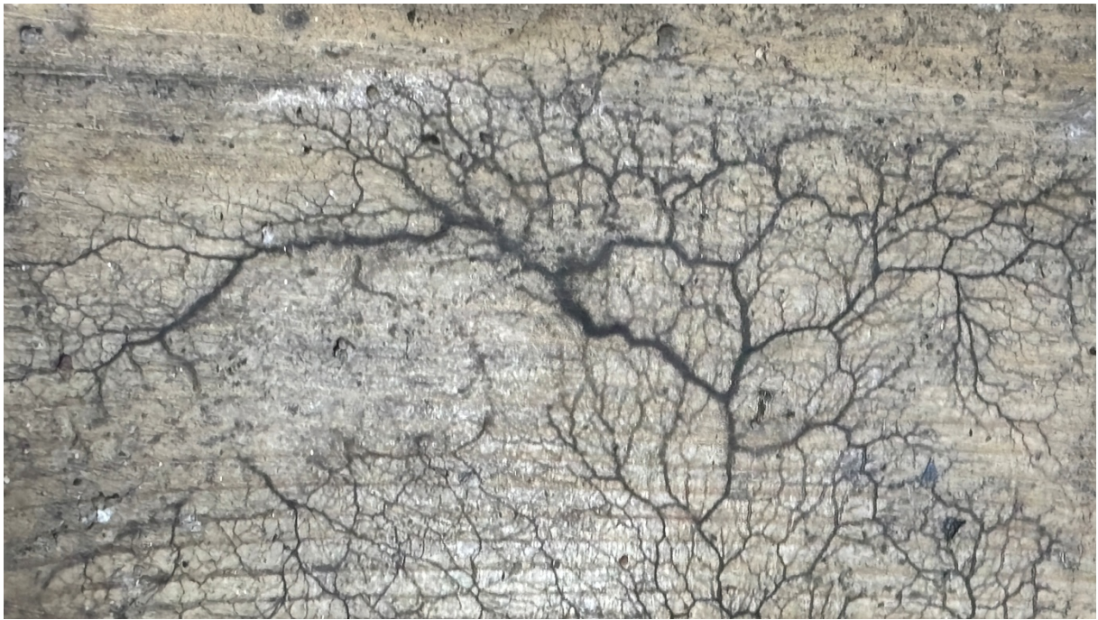
Fot. 19 Sznury grzybiczne grzyba domowego z gatunku Coniophora puteana znalezione pod pojemnikiem z wodą. Fot. E. Wilbik 2025r.
