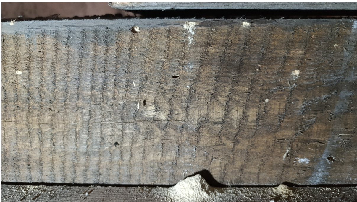
Fot. 27 Aktywne żerowiska ksylofaga z gatunku Hylotrupes bajulus . Otwory wylotowe owadów. fot. E. Wilbik 2025 r.
