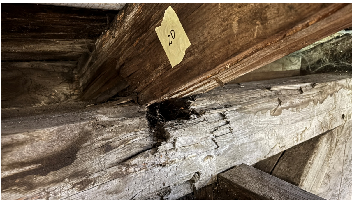
Fot. 8 Uszkodzenia mechaniczne krokwi i płatwi dachowej fot. P. Pakuła 2025r.
