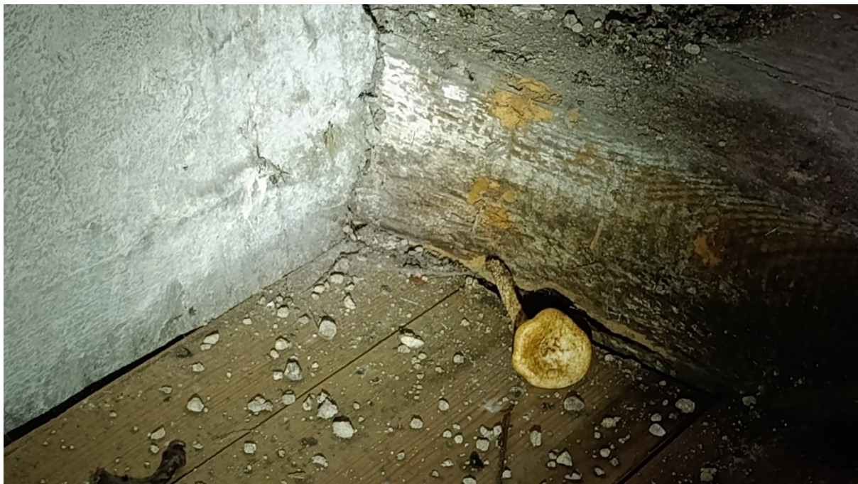
Fot. 12 Neolentinus lepideus wrośnięty w belkę więźby dachowej w badanym obiekcie. fot. P. Pakuła 2025r.
