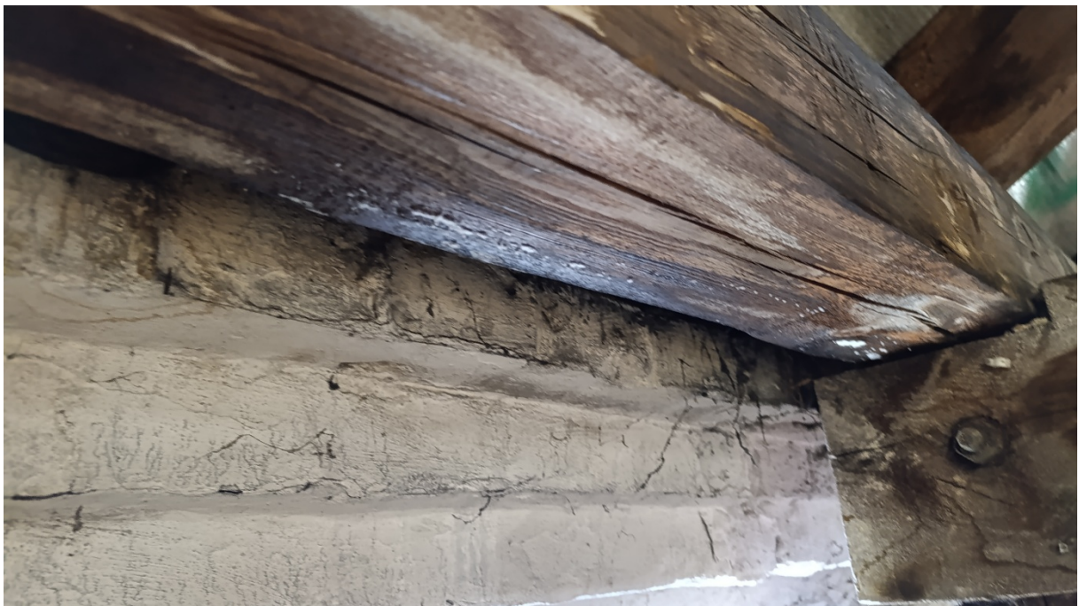
Fot. 20 Mokre drewno o wilgotności powyżej 40%. Na drewnie widoczna grzybnia grzyba domowego z gatunku Coniophora puteana . fot. E. Wilbik 2025r.
