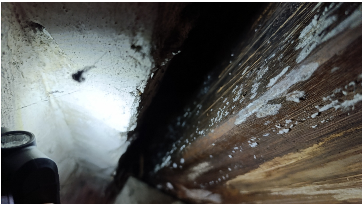
Fot. 21 Mokre drewno o wilgotności powyżej 40%. Na drewnie widoczna grzybnia grzyba domowego z gatunku Coniophora puteana . fot. E. Wilbik 2025r.
