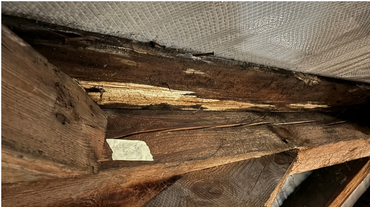
Fot. 12 Grzybnia i owocniki grzyba domowego z gatunku Trechispora farinacea fot. E. Wilbik 2025r.
