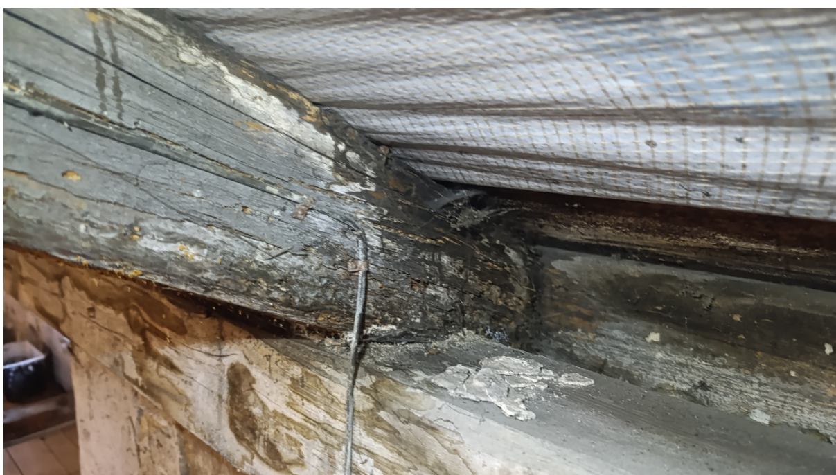
Fot. 26 Korozja biologiczna krokwi spowodowana porażeniem drewna przez grzyb domowy z gatunku Trechispora farinacea Fot. E. Wilbik 2025r.
