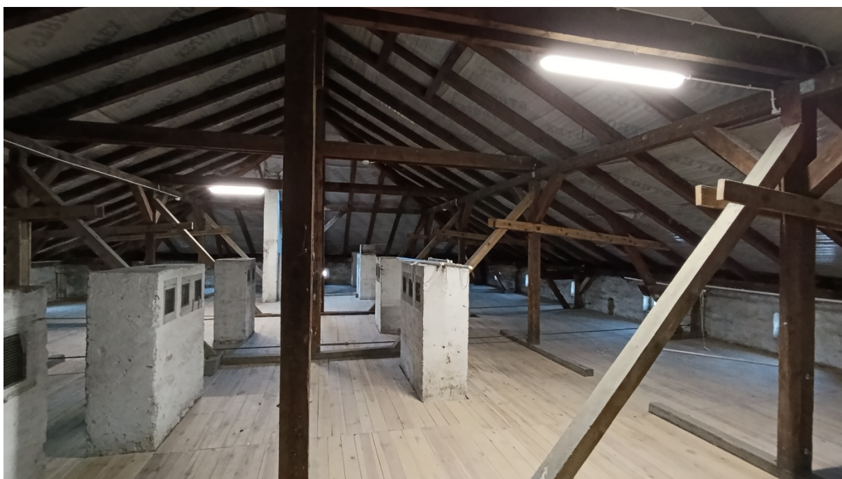
Fot. 30 Ogólny widok więzby dachowej. fot. P. Pakuła 2025r.
