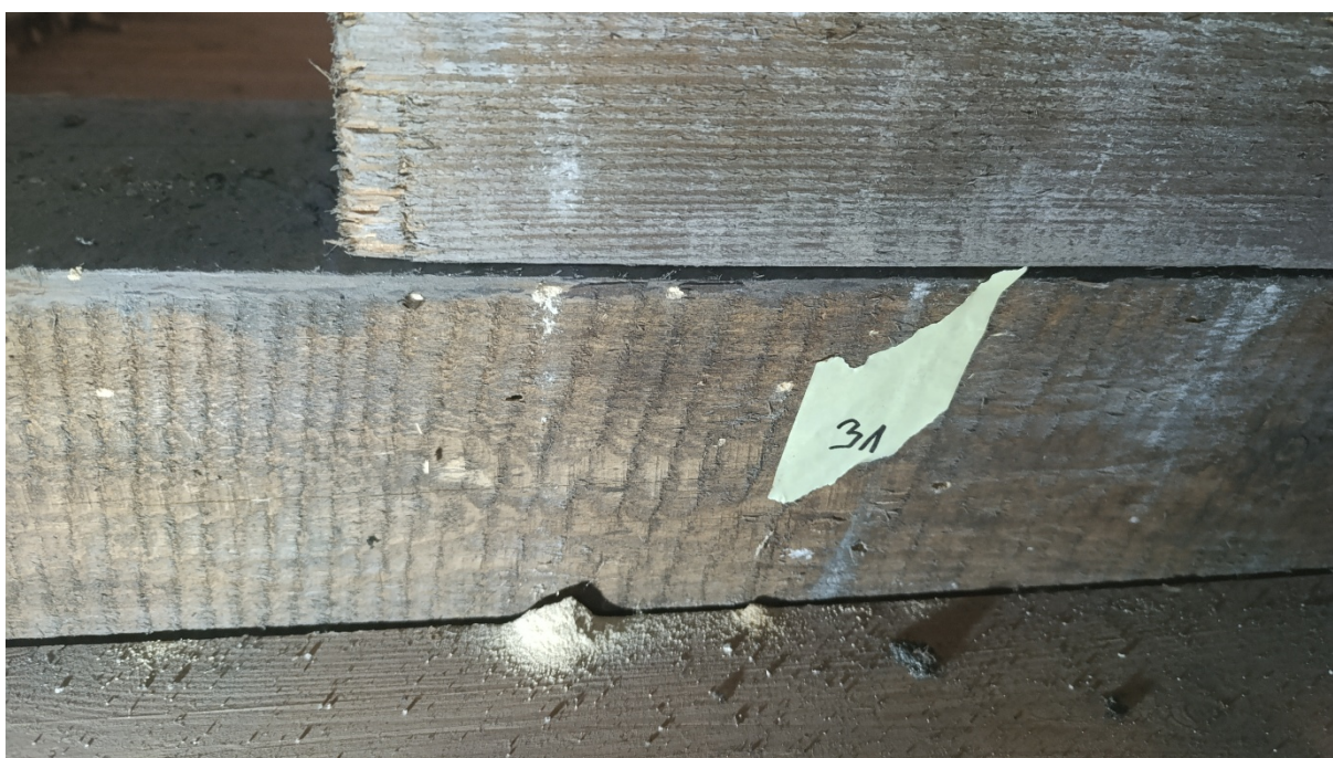
Fot. 10 Aktywne żerowisko ksylofaga z gatunku Hylotrupes bajulus fot. P. Pakuła.2025r.
