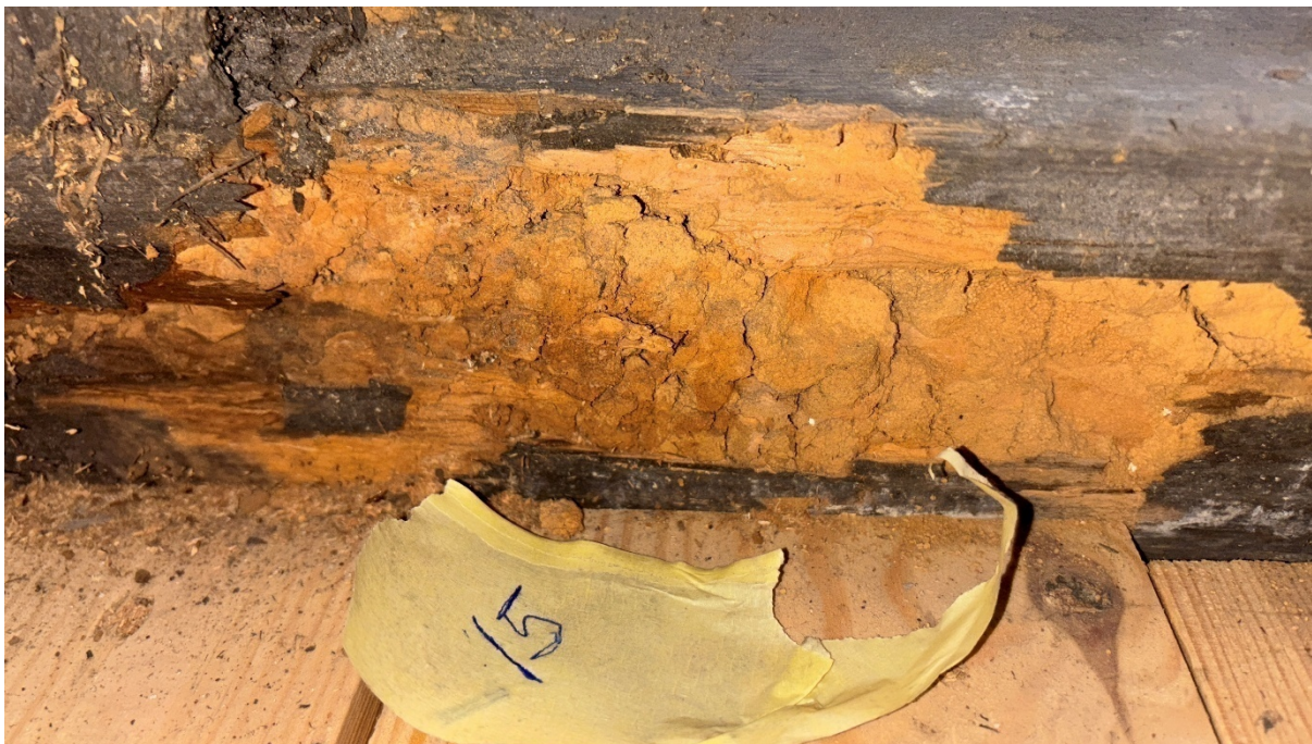
Fot. 23 Drewno poziomej podpory kleszcza zniszczone przez ksylofagi z gatunku Hylotrupes bajulus . fot. P. Pakuła 2025r.
