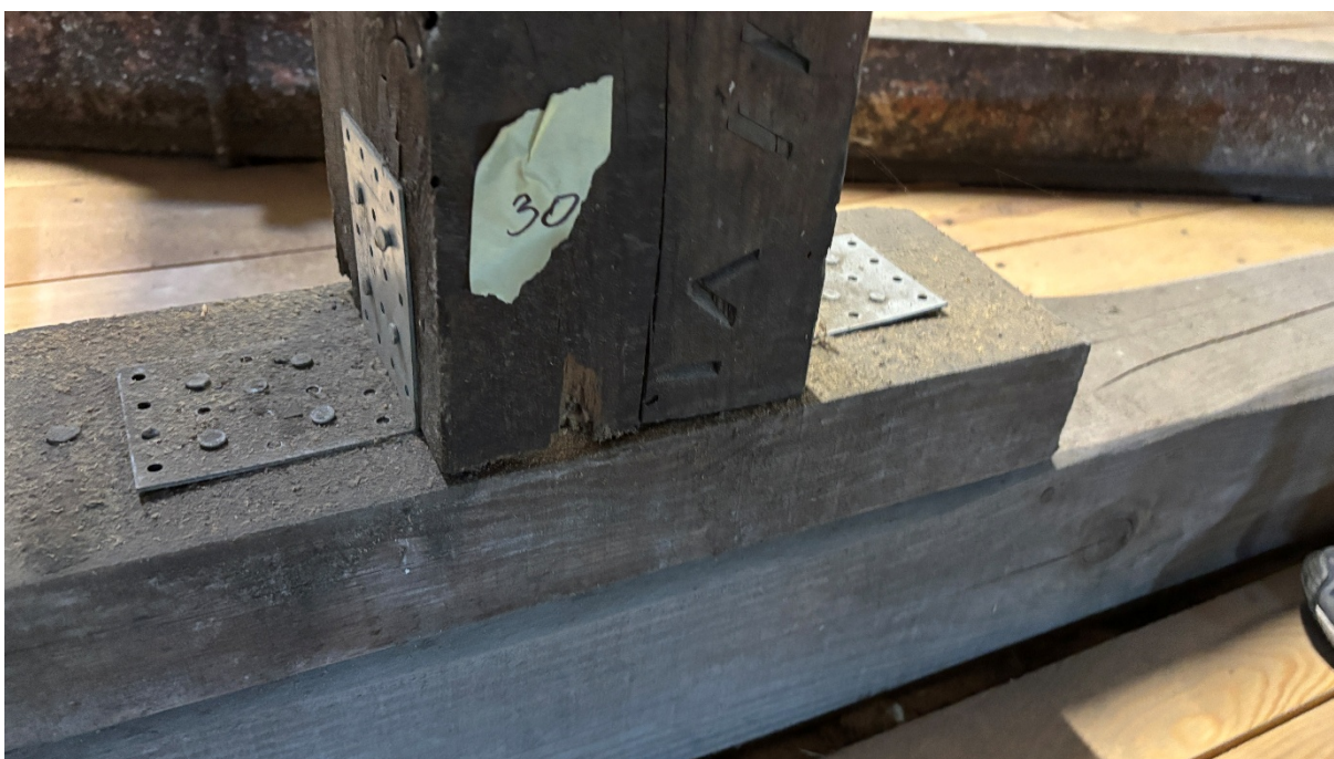
Fot. 24 Aktywne żerowisko ksylofaga z gatunku Hylotrupes bajulus . fot. P. Pakuła 2025r.
