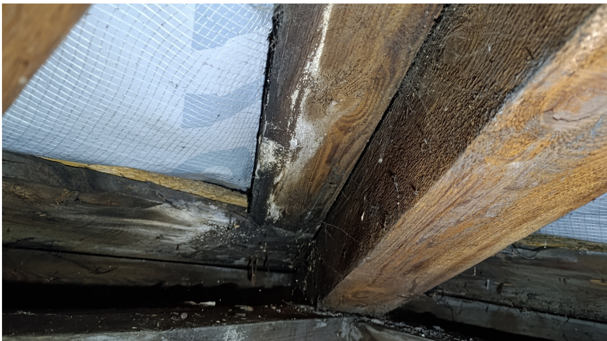
Fot. 6 Grzybnia i owocniki grzyba domowego z gatunku Trechispora farinacea fot. E. Wilbik 2025r.
