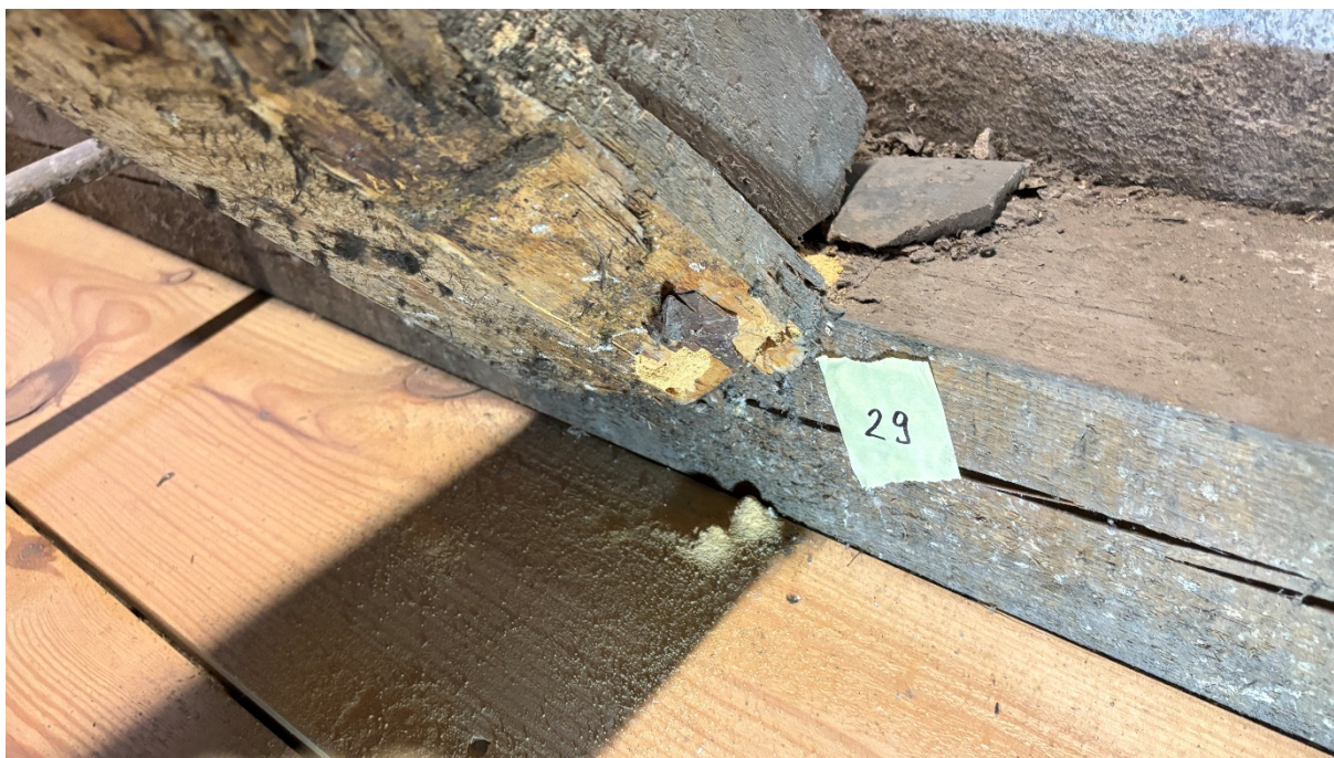
Fot. 13 Aktywne żerowiska ksylofaga z gatunku Hylotrupes bajulus . Widoczne znaczne ubytki drewna powstałe w wyniku żerowania larw zidentyfikowanego chrząszcza. fot. E.Wilbik 2025r.
