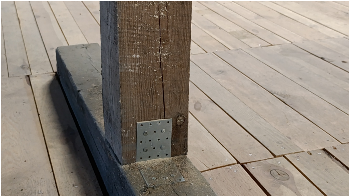
Fot. 1 Świeża mączka drzewna świadcząca o aktywnym żerowisku technicznego szkodnika drewna z gatunku Hylotrupes bajulus fot. E. Wilbik 2025r.
