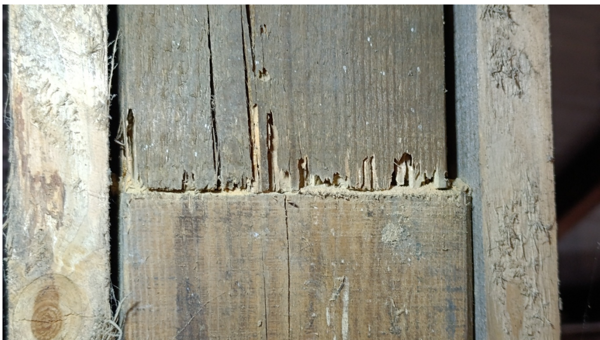
Fot. 14 Aktywne żerowiska ksylofaga z gatunku Hylotrupes bajulus . widoczne połączenie pierwotnej tarcicy (góra) i wtórnej z bocznymi nadbitkami. fot. E. Wilbik 2025r.
