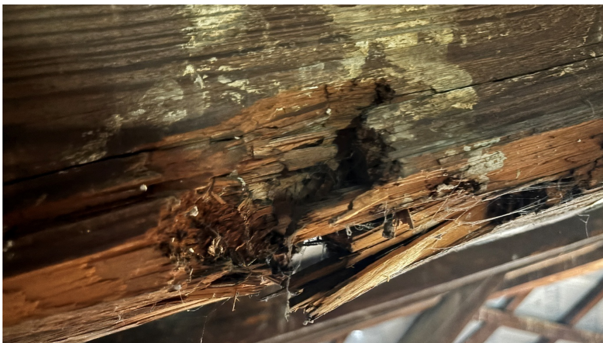
Fot. 7 Uszkodzenie mechaniczne krokwi. fot. P. Pakuła 2025r.
