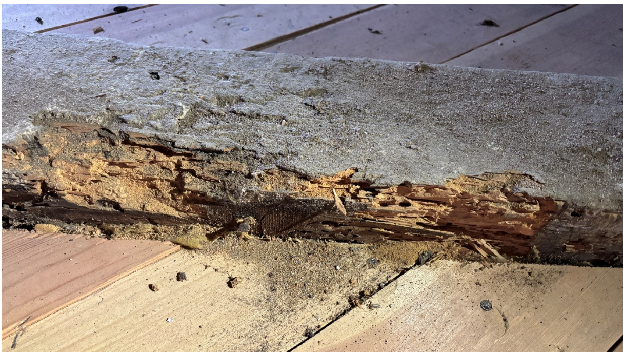
Fot. 2 Nieaktywne żerowiska ksylofaga z gatunku Hylotrupes bajulus fot. E. Wilbik 2025r.
