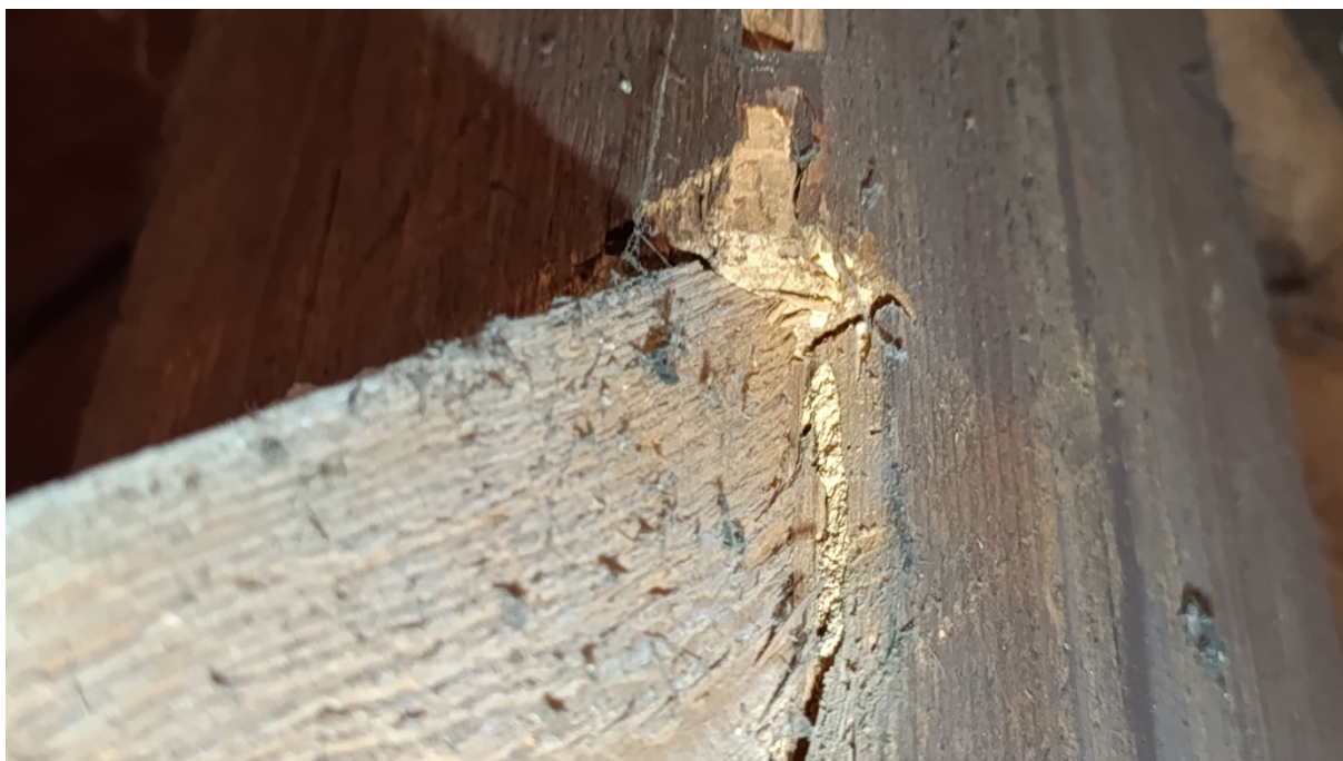
Fot. 15 Aktywne żerowiska ksylofaga z gatunku Hylotrupes bajulus . Ksylofagi żerują w miejscu połączenia pierwotnego słupa z wtórnym mieczem więźby dachowej. Taka sytuacja ma miejsce na wszystkich połączeniach tego typu w badanej więźbie dachowej. fot. E. Wilbik 2025r.
